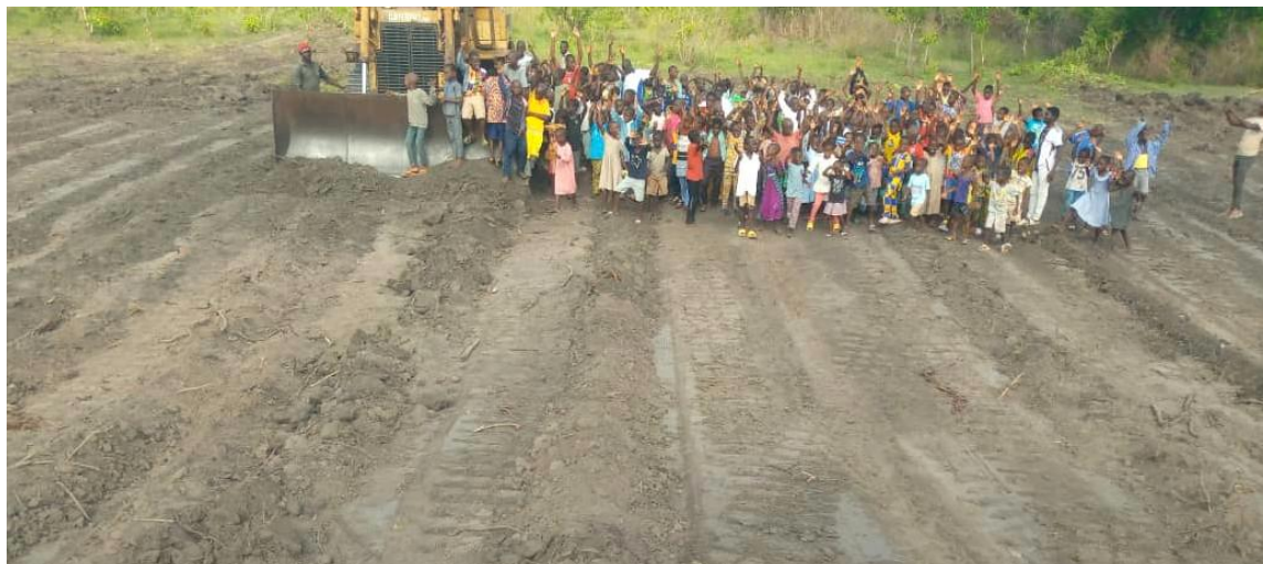
Bild: Die Kinder freuen sich über die Arbeiten zur Errichtung des Wasserrückhaltebeckens
